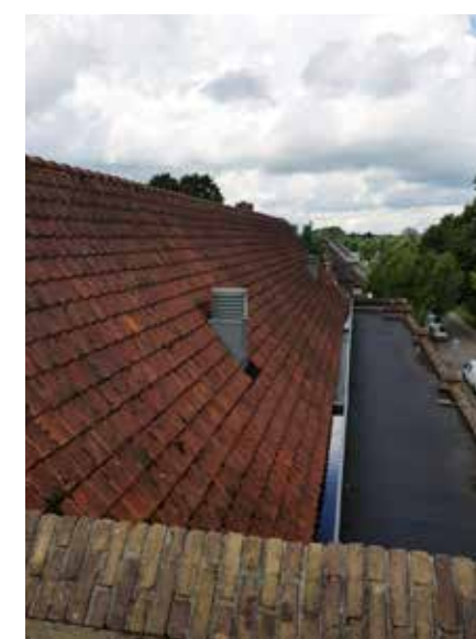
Toe- en afvoer dakkappen.
